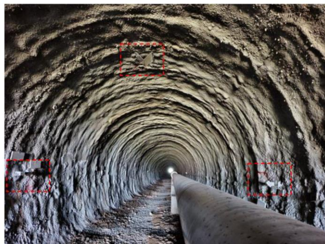
Figura 5. Sensores instalados em uma das seções em esquema de triangulação.
